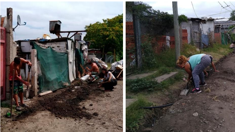
Figura 10. Realización de la red de agua
